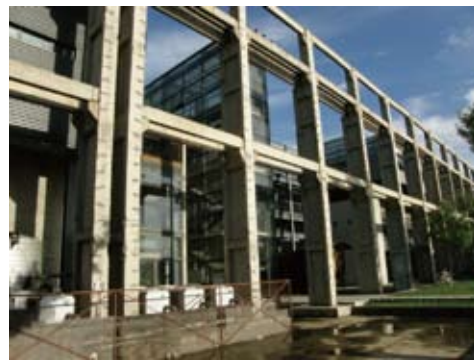
水晶城舊廠房整修為社區會館
