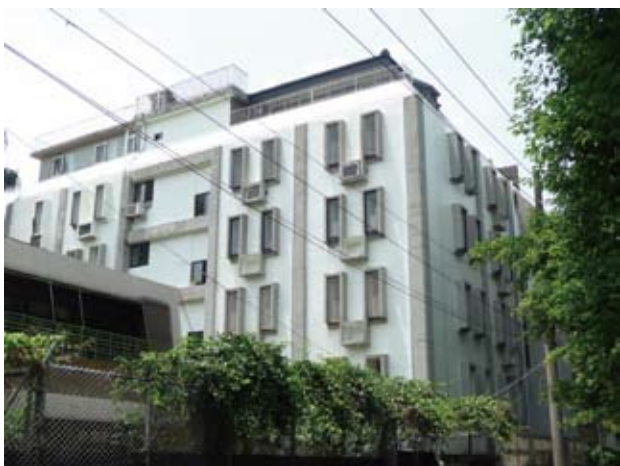
更新後改善漏水建物立面煥然一新（照片由老圍造園工程提供）
